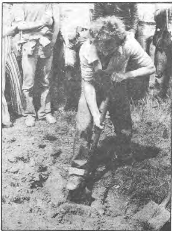
Das „Buddel-in“ — symbolische Spatenstiche für die neue Schule
